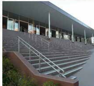
生徒玄関前階段手摺 一式
